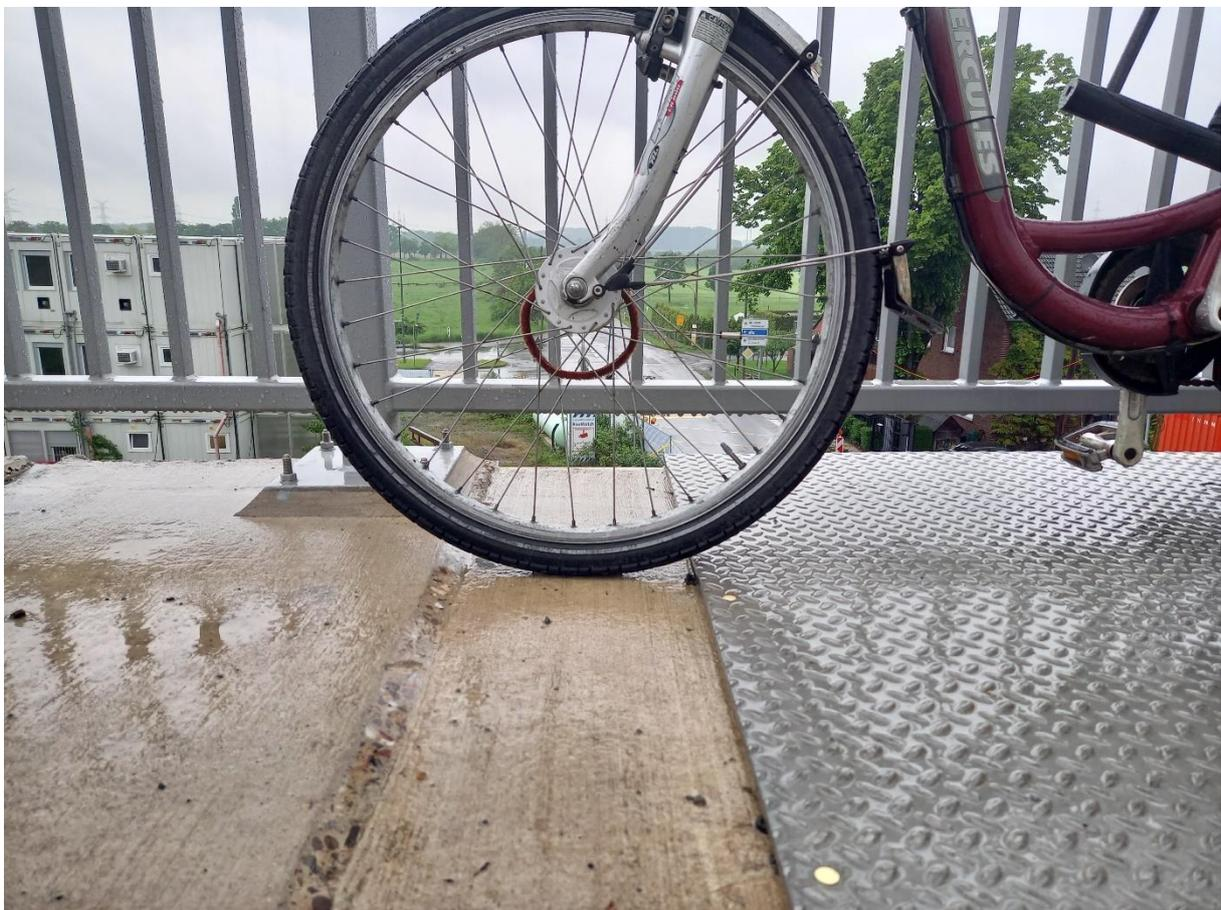
Abb. 2: Dehnungsfuge Leverkusener Brücke (A1), FR Trier
