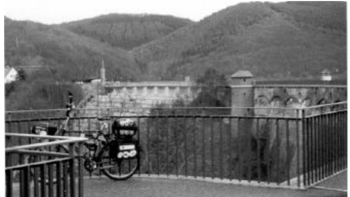
An der Staumauer der Urfttalsperre Foto: erko
