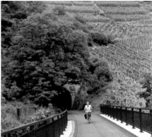
Tunnelausfahrt bei Mayschoß Foto: erko
