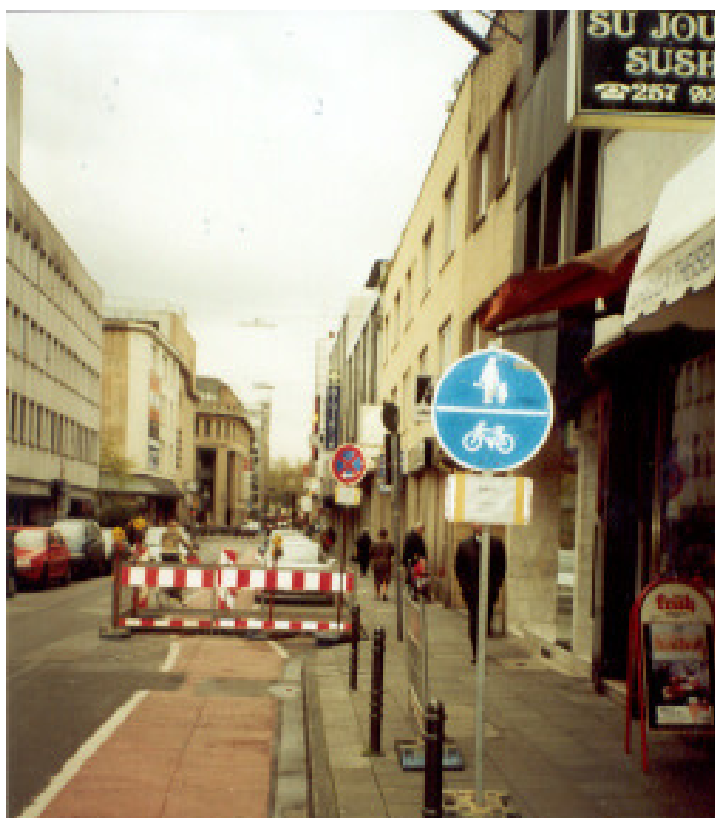
Auf dem Berlich I Hier endet in Fahrtrichtung Neumarkt, was nirgendwo begann: der gemeinsam genutzte Fuß- und Radweg
